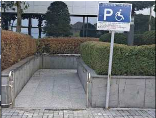
장애인주차구역 안내표지판이 주차장이 아닌 건물 입구 경사로에 설치되어 있는 시민회관
